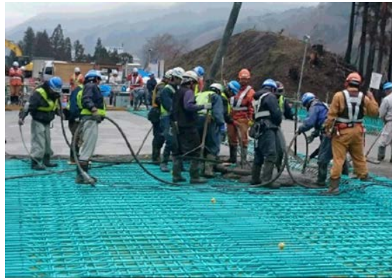
長寿命の橋梁の建設
