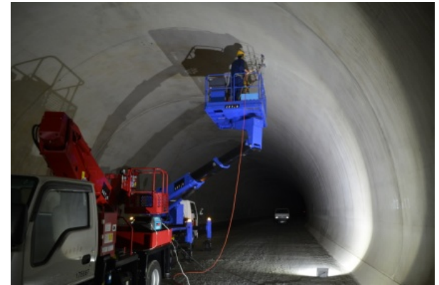
山岳トンネルの品質調査
