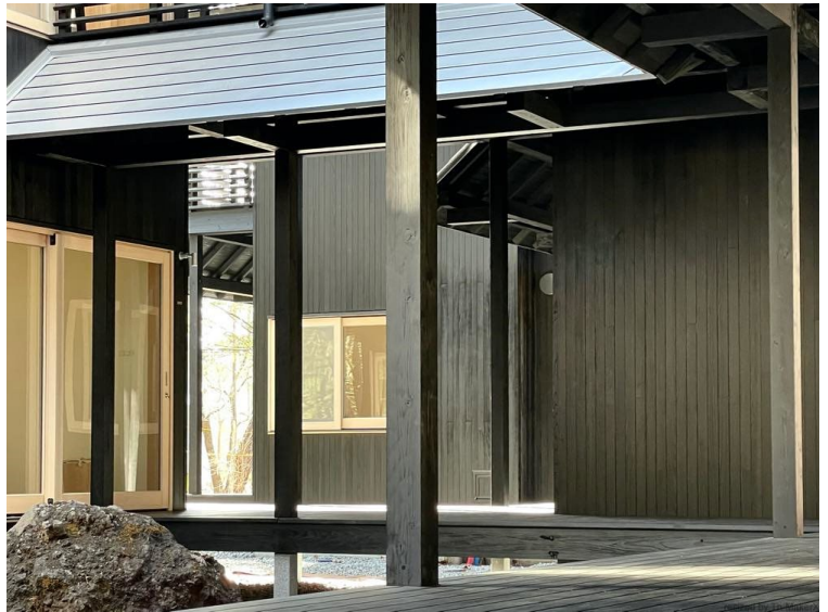
写真：西沢立衛建築設計事務所
