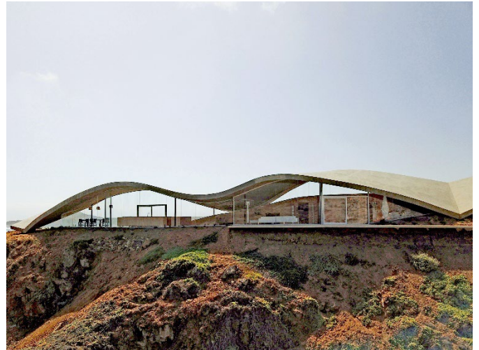
写真：西沢立衛建築設計事務所
