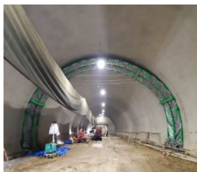
山岳トンネル養生システム
