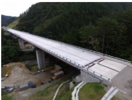
ひび割れゼロの長寿命の橋
